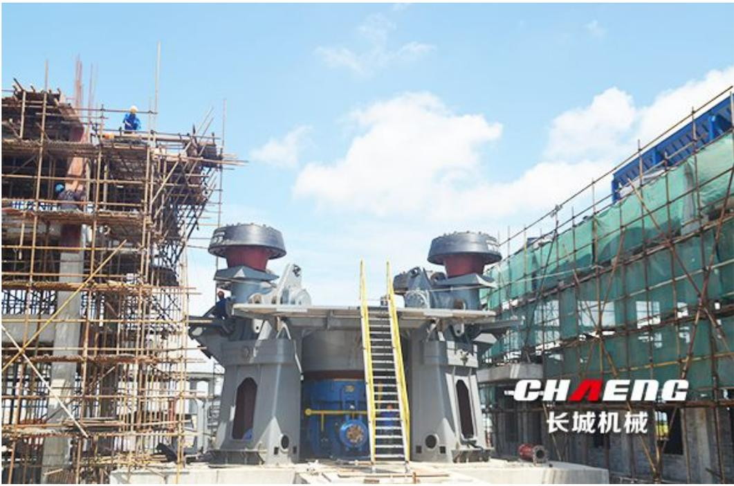
图：上海宝钢矿渣立磨机安装图，左右摇臂可以带动磨辊翻转出来进行检修
